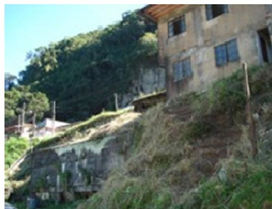
FOTO 31 - Moradia precária muito próxima ao talude de corte, e encosta rochosa a montante
