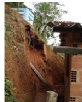
Foto 156 - Casa sem estrutura próxima ao talude
