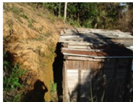
Foto 170– Taludes de corte sem proteção
