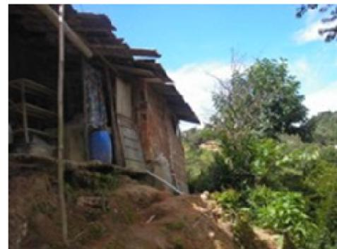
Foto 214– Construções sem estrutura na encosta
