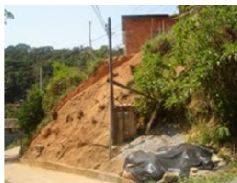
FOTO 66 - Taludes sem proteção superficial
