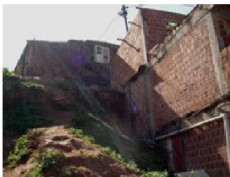
Foto 130- Moradia precária a jusante do talude
