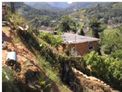
Foto 235 – Escorregamento na crista do talude
