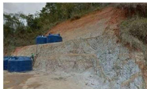
Foto 052 – Corte e deficiência de drenagem no talude.
