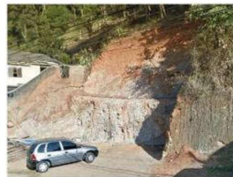
Foto 004 – Corte inadequado e deficiência de drenagem.
