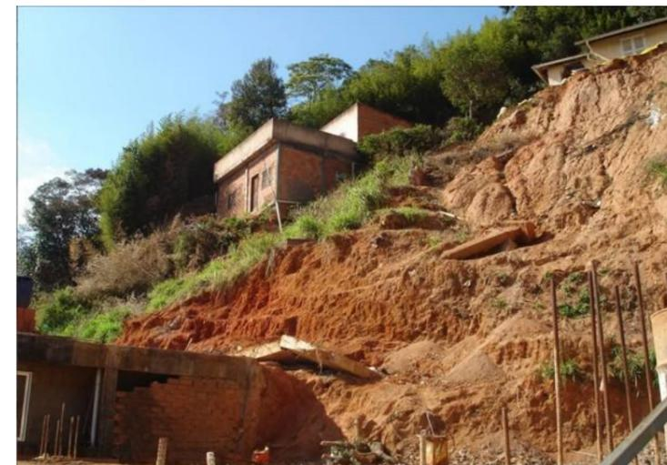
**Foto 3.11** – Deficiência de drenagem e corte inadequado.
