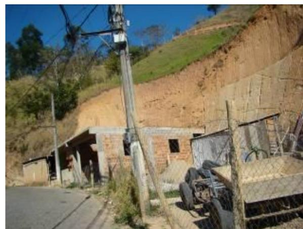
Foto 012 – Corte inadequado do talude
