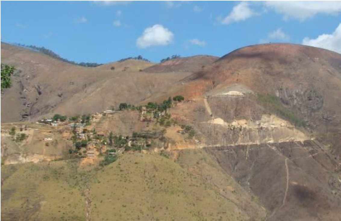
Foto 012 – Avanço da ocupação em talude sem proteção superficial, com execução de cortes inadequados desencadeando processos erosivos na encosta.
