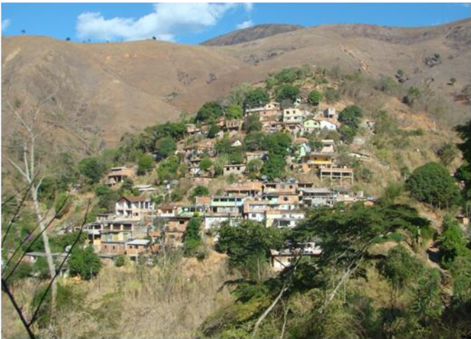
Foto 013 – Ocupação consolidada na encosta.
