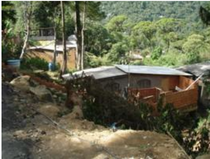
Foto 3.16 – Moradia construída no talvegue.
