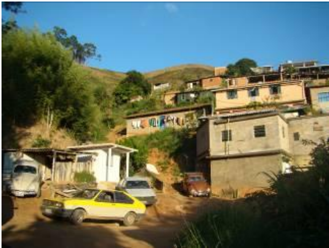
Foto 018 – Moradias precárias com ausência de infraestrutura.
