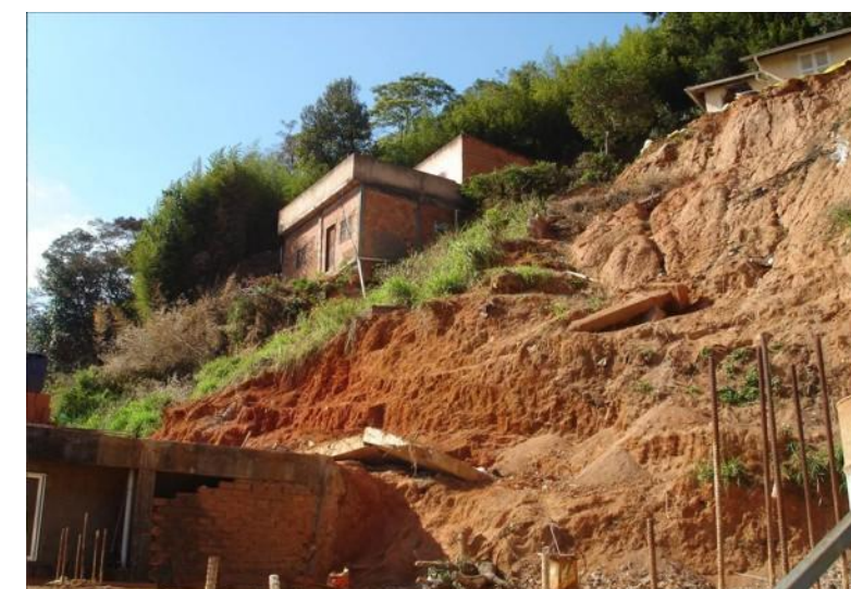
Foto 3.11 – Deficiência de drenagem e corte inadequado.
