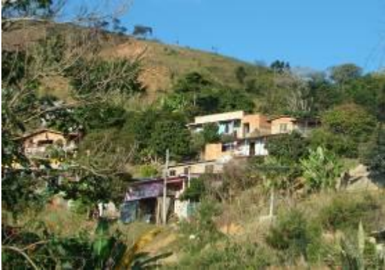
Foto 029 – Ocupação na encosta.
