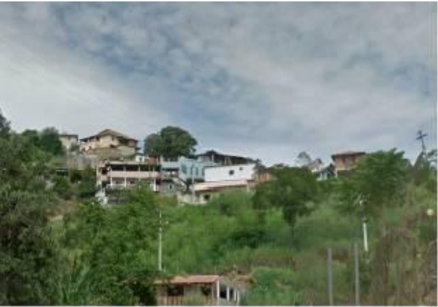
Foto 033 – Ocupação Consolidada na encosta.
