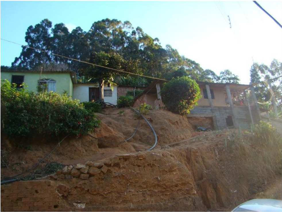
Foto 019 – Assentamento sem infraestrutura com acessos precários.
