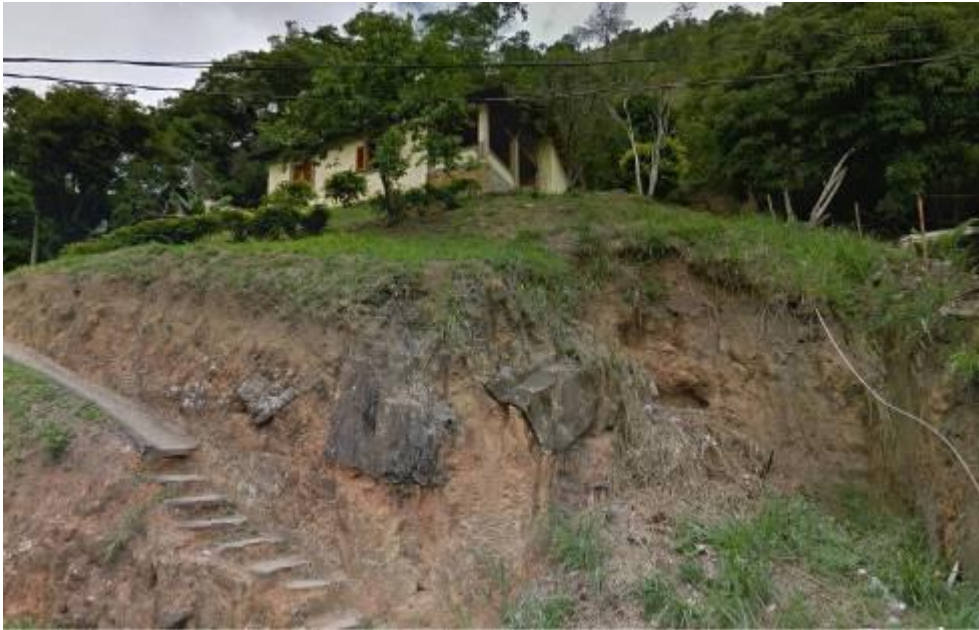
Foto 006 – Moradia construída em local de depósito de blocos rochosos.
