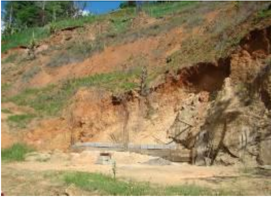
Foto 034 – Execução de cortes inadequados desencadeando processos erosivos na encosta.
