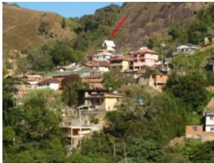
Foto 3.3 – Moradias implantadas na base do maciço rochoso.
