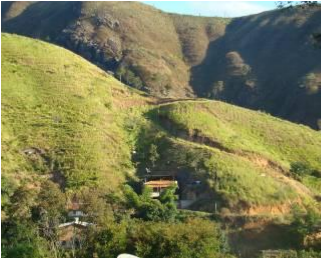
Foto 026 – Construções na linha de drenagem natural.
