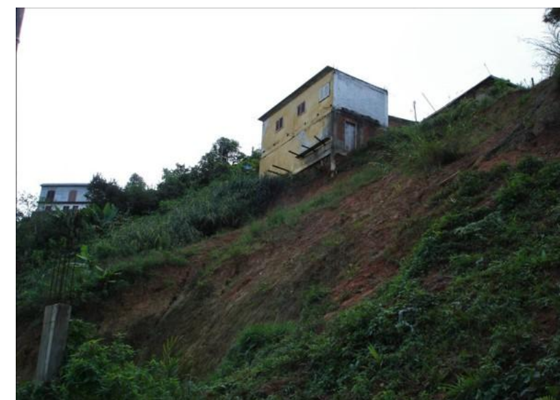
Foto 3.11 – Deficiência de drenagem e corte inadequado.
