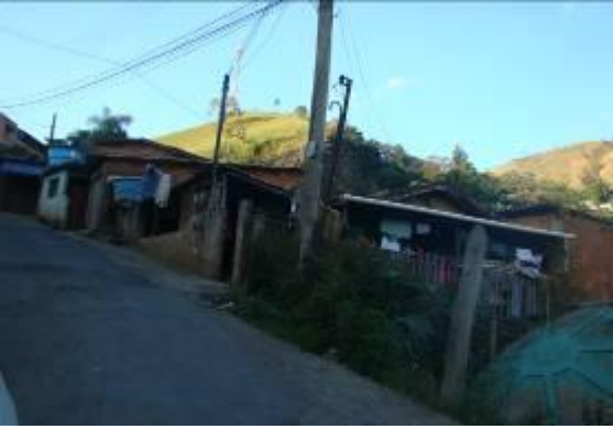
Foto 030 – Assentamentos sem infraestrutura.
