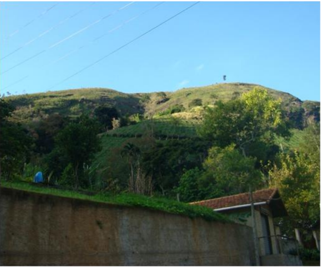
Foto 022 – Construções implantadas próximas ao afloramento rochoso.
