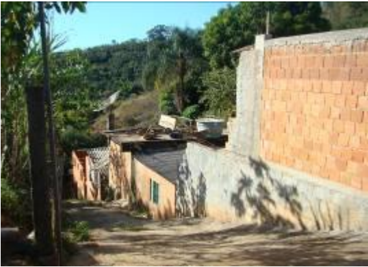
Foto 041 – Moradias implantadas no caminho das águas.
