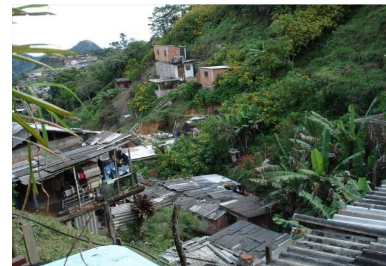
Foto 3.10 – Moradias muito precárias implantadas à meia encosta.
