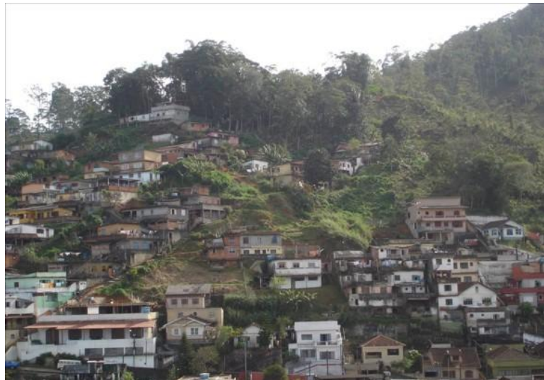
Foto 3.7 – Ocupação consolidada na encosta.
