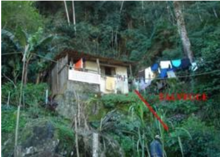
Foto 3.16 – Moradia construída no talvegue.
