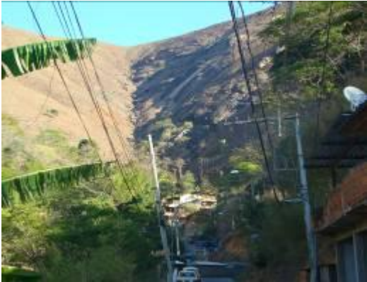
Foto 015 – Construções na direção das linhas de drenagens.
