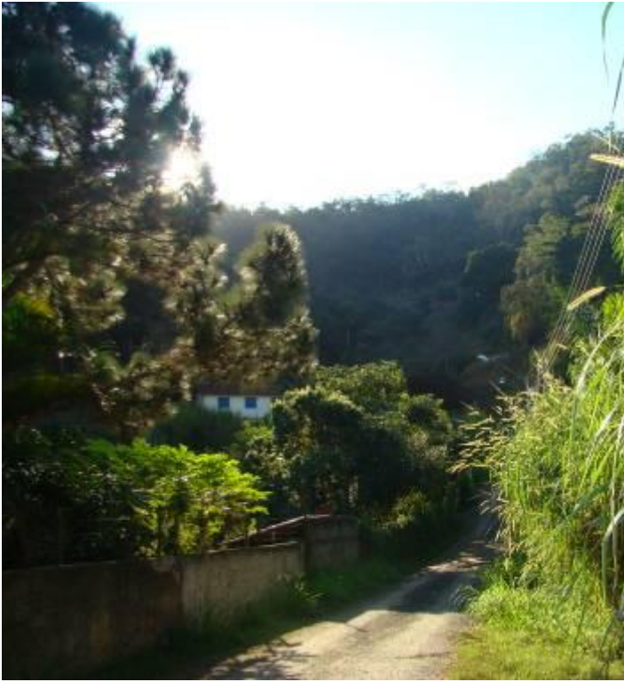
Foto 036 – Construções dentro do talvegue e na base da encosta.
