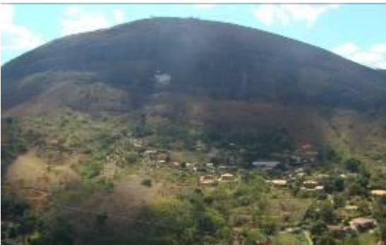
Foto 008 – Vista geral da ocupação.
